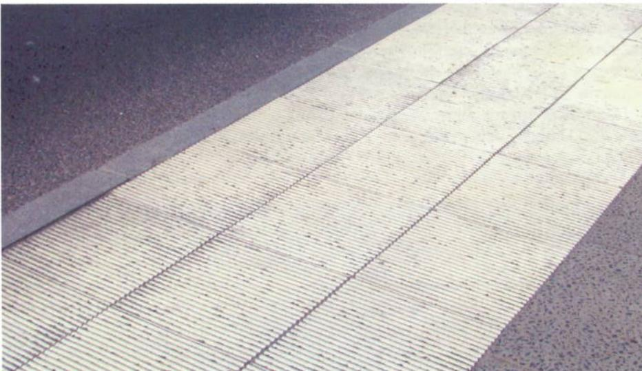
**Unabhängige Mobilität ohne fremde Hilfe: Bodenindikatoren als Teil des Orientierungssystems im öffentlichen Raum sind für blinde und sehbehinderte Menschen wichtige Warn- und Leitelemente. Quelle: REC Bauelemente GmbH**
