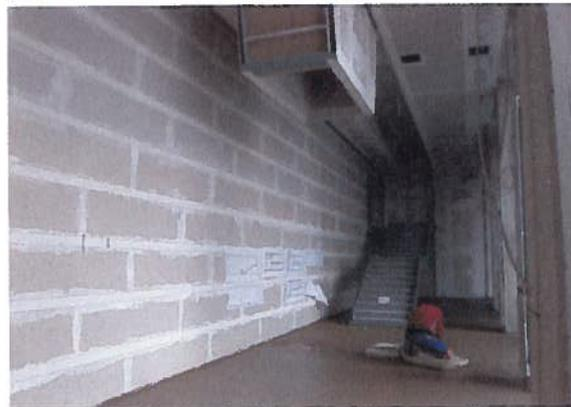
Die Handwerker verklebten die Stuccolith-Elemente in Abstimmung mit der Firma Knauf Gips an einer geschossübergreifenden Trockenbauwand aus Gipskartonplatten
