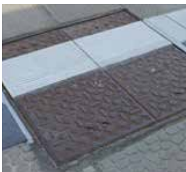
Verlegung auf einem Schachtdeckel
