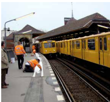
Verlegung bei laufendem Verkehr
